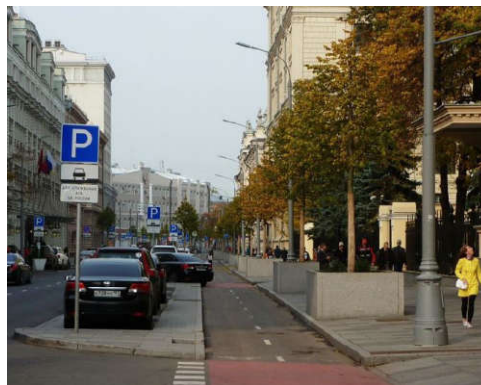
Выделенная двухсторонняя велодорожка, связанная с Новым районом через Горсад Обособлена от проезжей части и пешеходного пространства, экономит пространство улицы по сравнению с двумя односторонними велодорожками
