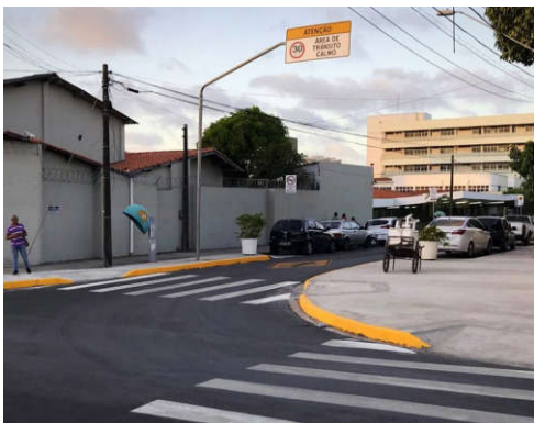
Сужение радиусов поворотов и ограничение скорости Используется для успокоения движения транспорта
